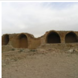
Мшатта, северная стена
