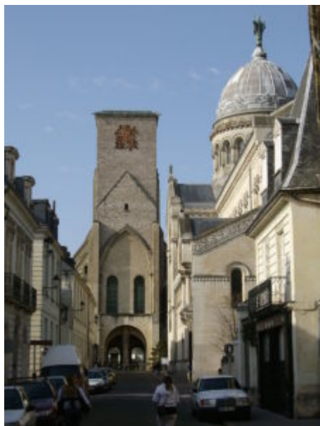
Башня Карла Великого, восстановленная часть средневековой базилики Святого Мартина; справа — современное здание базилики
