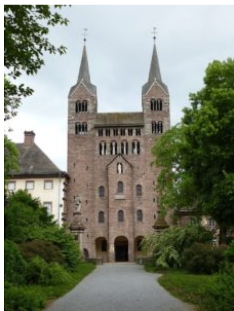
Церковь монастыря в Корби, IX в. Западный фасад
