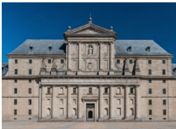
Эскориал. Западный фасад
