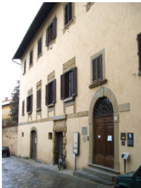
Дом Вазари в Ареццо. Фасад
